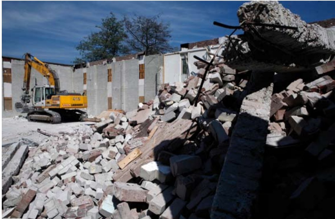
Sloop van het Patrimoniumgebouw op het Bezaanachtplein
